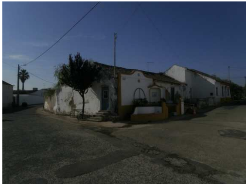
Figura 9 – Espaços públicos sem condições para potenciar a permanência da população, Largo entre a Rua de Santo António e a Rua Joaquim Gonçalves Ferreira.
