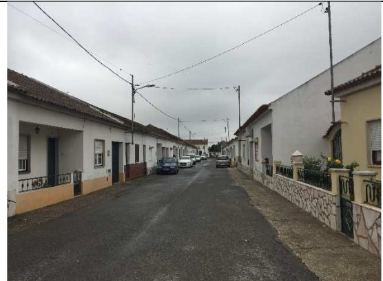
Figura 8- Arruamentos constituídos sobretudo por edifícios de 1 piso
