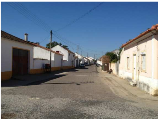
Figura 5 – Arruamentos constituídos sobretudo por edifícios de 1 piso
