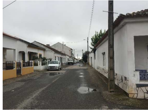
Figura 8 – Largura dos passeios insuficiente, Rua do Casal Centeio. Arruamento com aspecto espacial e visual pouco atractivo.
