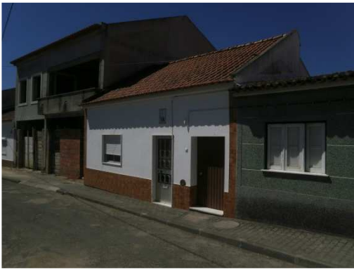
Figura 1 – Utilização de materiais de revestimento dissonantes
